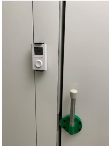
Abbildung 4: Installation des Raumthermostat neben der Tür des Innenklimaraums
