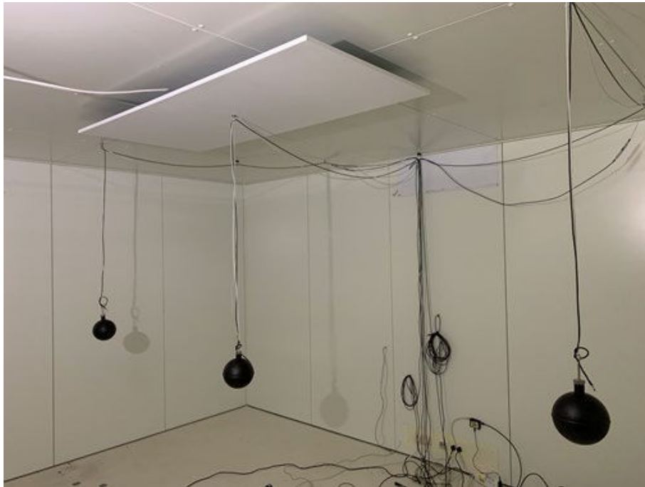
Abbildung 7: Heizgerät Infrarotheizung an der Decke – Position mittig
