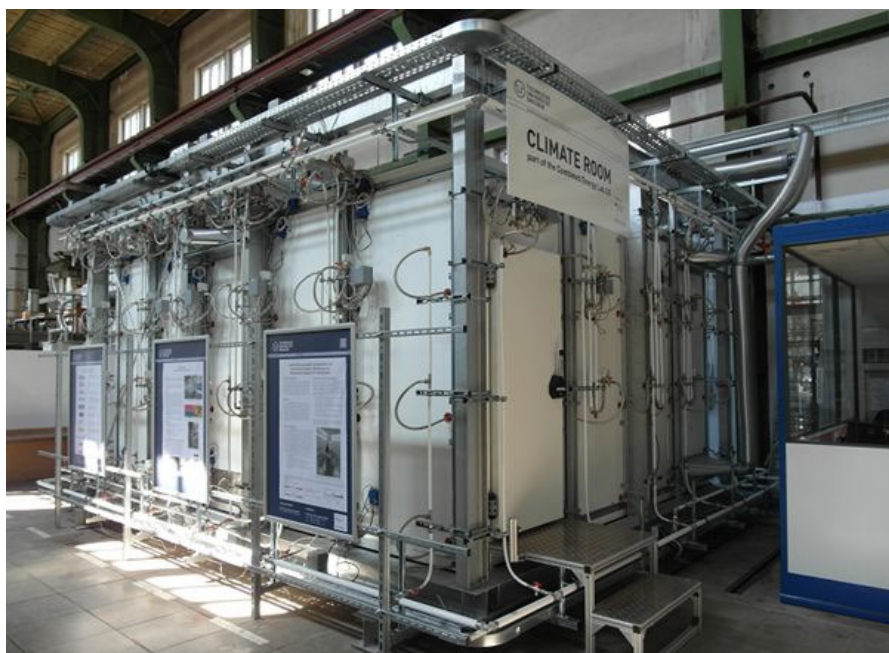
Abbildung 1: Innenklimaraum der TU Dresden
