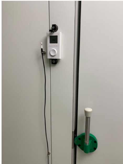
Abbildung 9: Raumthermostat neben der Tür inkl. Vergleichsmessstelle
